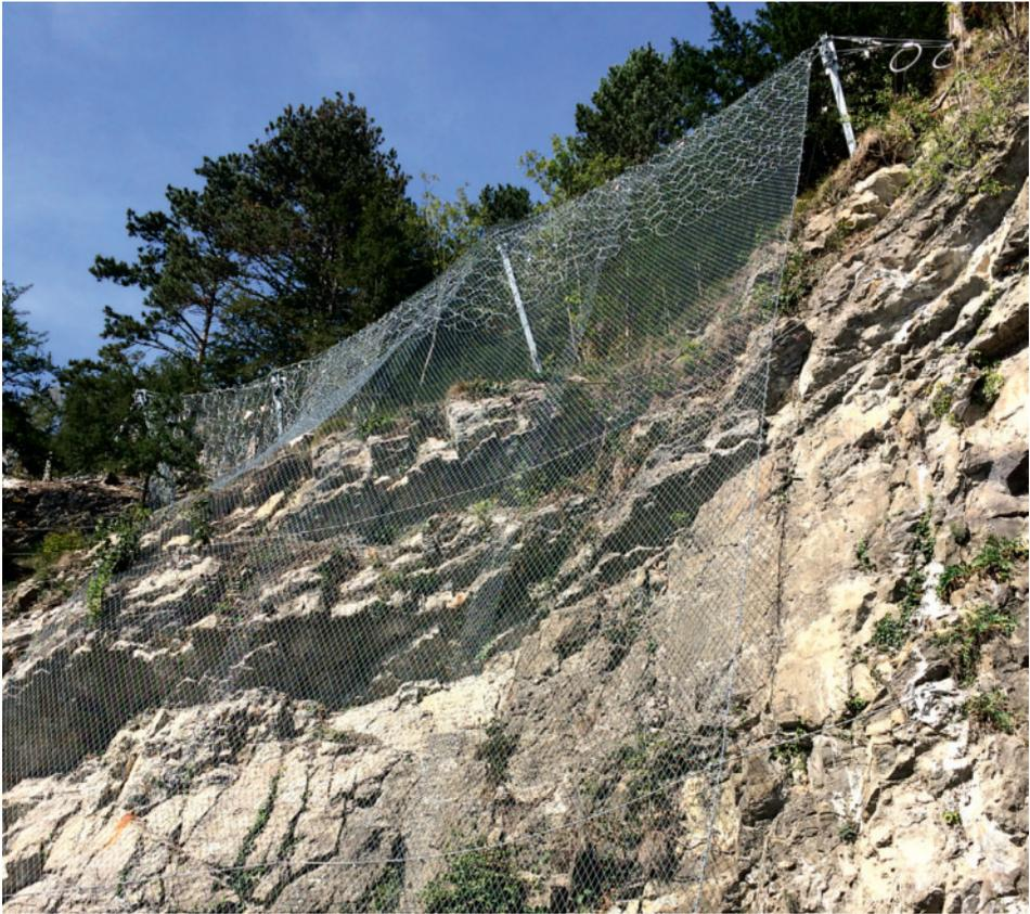
schutznetze (mit maximalen Energieaufnahmen von 100 bis 500 kJ) vor. Die Netzlänge – über alle sechs Steinschlagschutznetze – beträgt 191 m.
