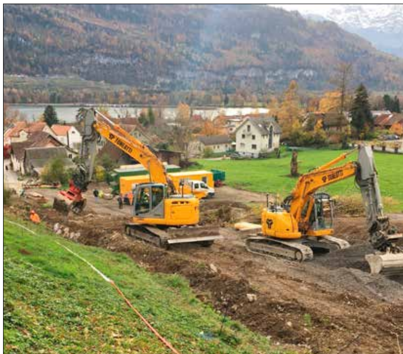
Die Bauarbeiten am Sagenbach sind in vollem Gang.
