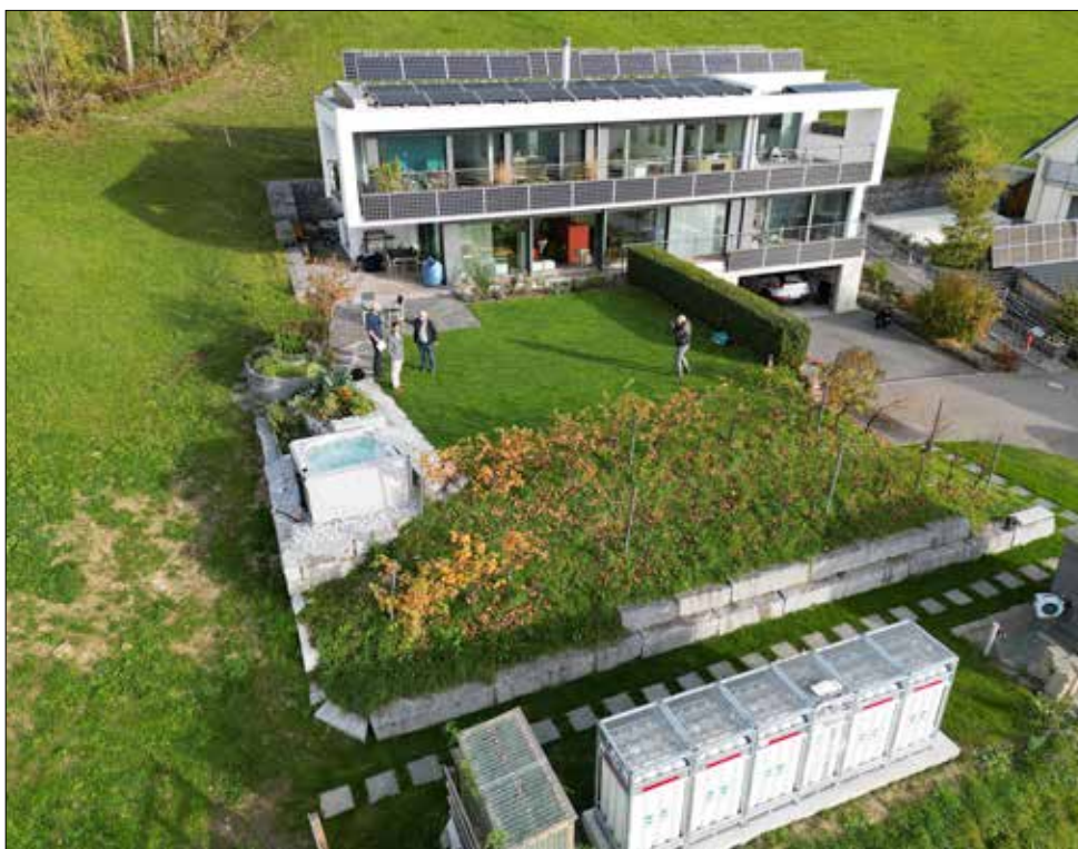
Künftig ist das Haus von der Energie unabhängig. Im Vordergrund das Lager für den Wasserstoff (wird noch verkleidet).
