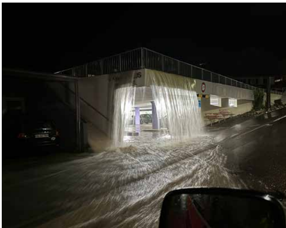
Ein Wasserfall ergiesst sich über die Einfahrt des Parkhauses Ruestel.
