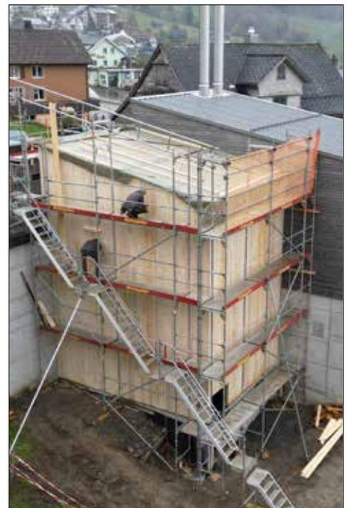
*Der Speicher wird mit einer Wand und einem Dach versehen (Stand: 19.11.2024).*
