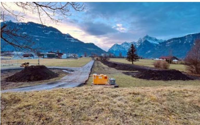
Abtragung der Humusschicht und Erstellung des Baugrundes
