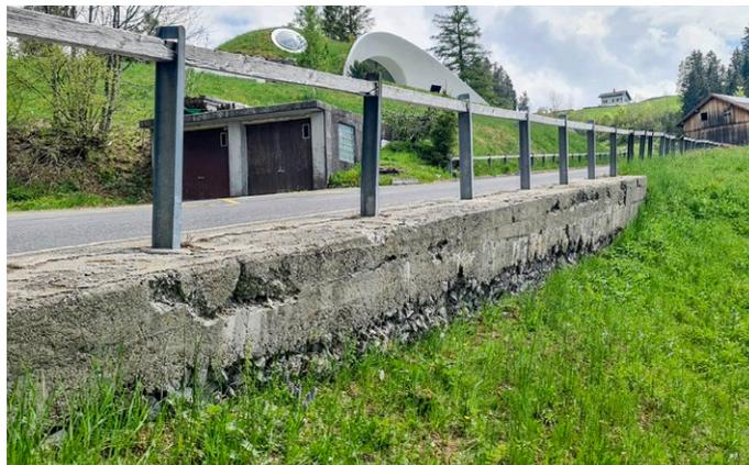
Abgerutschte Stützmauer mit Steinkörben und Betonkorden
