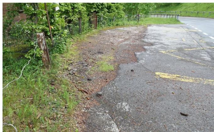
Bushaltestelle im Obern; durchgehend Risse, Belagsrand abgebröckelt, überwachsene Abschlüsse
