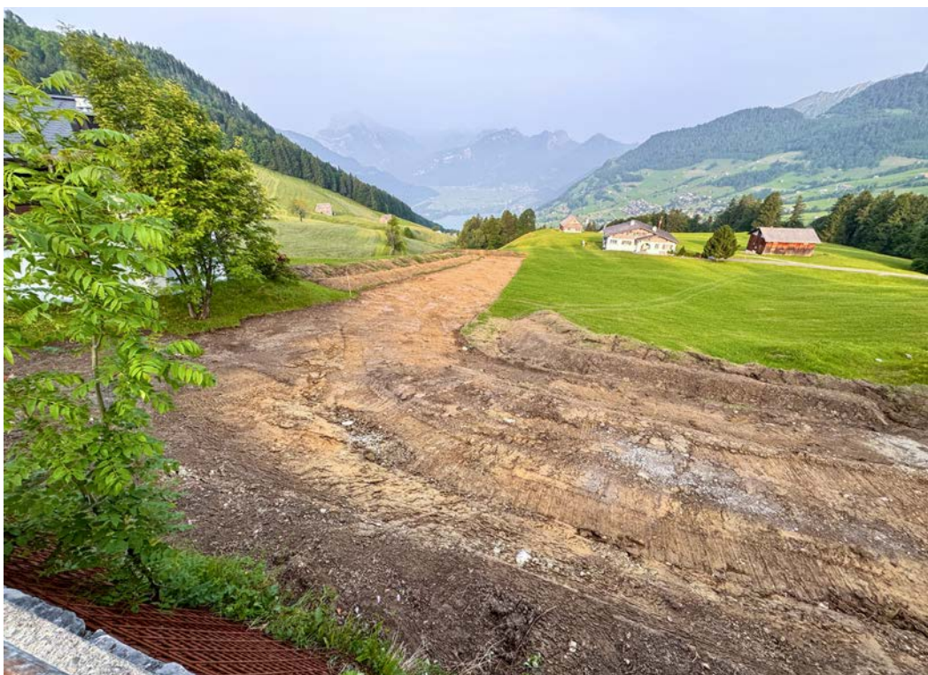
Die Bauarbeiten im Untersellen für den Ersatz der Abwasserleitungen haben begonnen.
