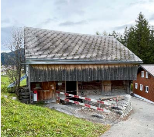
Die Bauarbeiten bei der öffentlichen Toilette auf dem Chapf haben gestartet. © Roman Gmür
