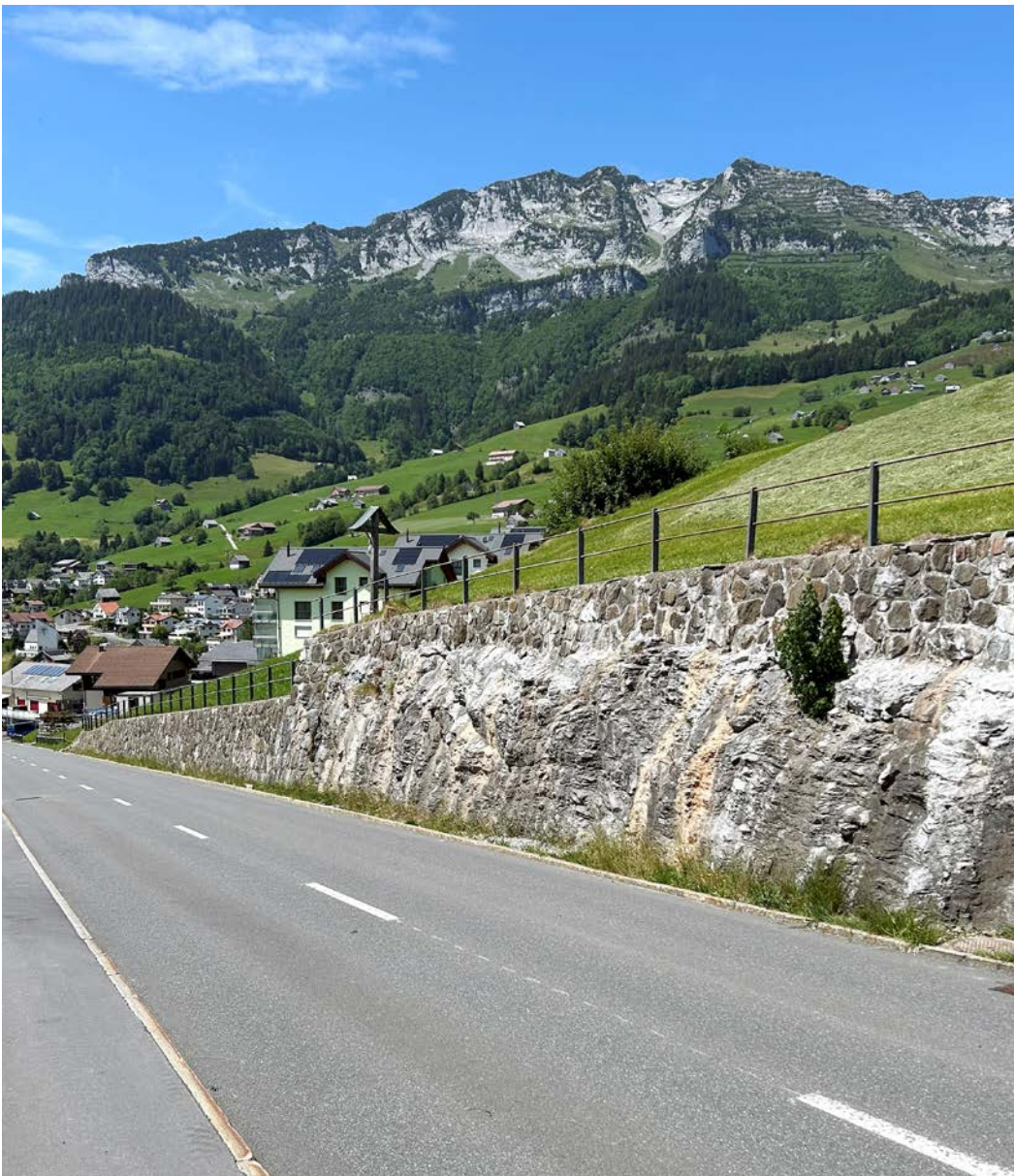
Einzelne Mauerkronenabschnitte entlang der Arvenbühlstrasse werden in diesem Jahr saniert.
