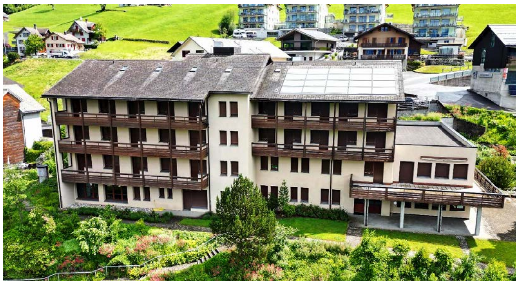
In diesem Gebäude sollen 14 neue Wohnungen entstehen.
