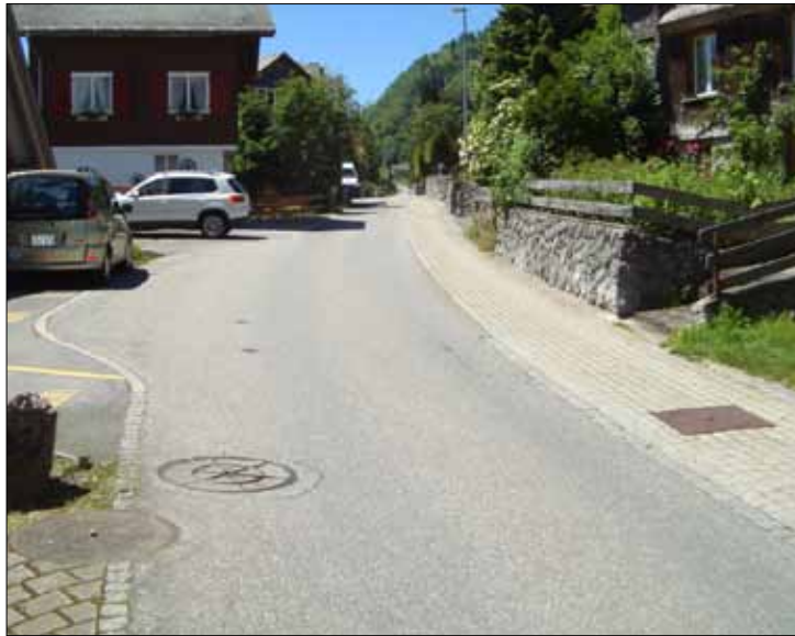
Aeschen- und Grossgadenstrasse sind stellenweise sanierungsbedürftig. Bild: Roman Gmür
