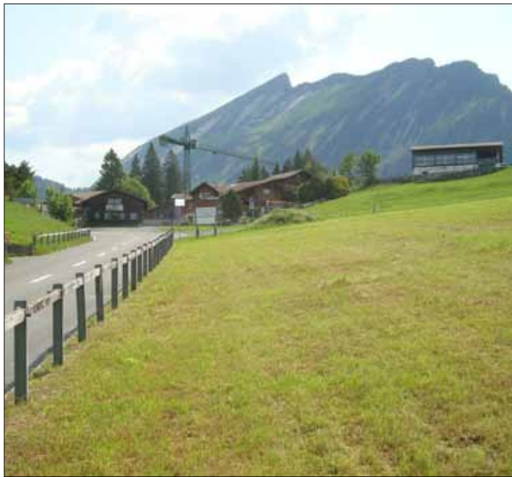
Im Lachen werden Leitungen umgelegt und neu gebaut. Bild: Roman Gmür
