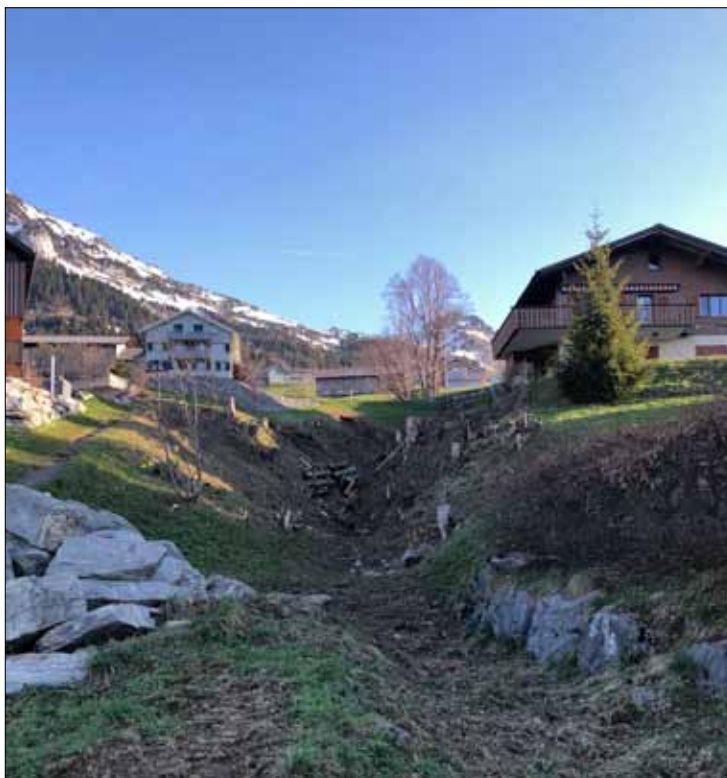
Die Bauarbeiten am Hänslibach beginnen am 6. Mai 2019.
