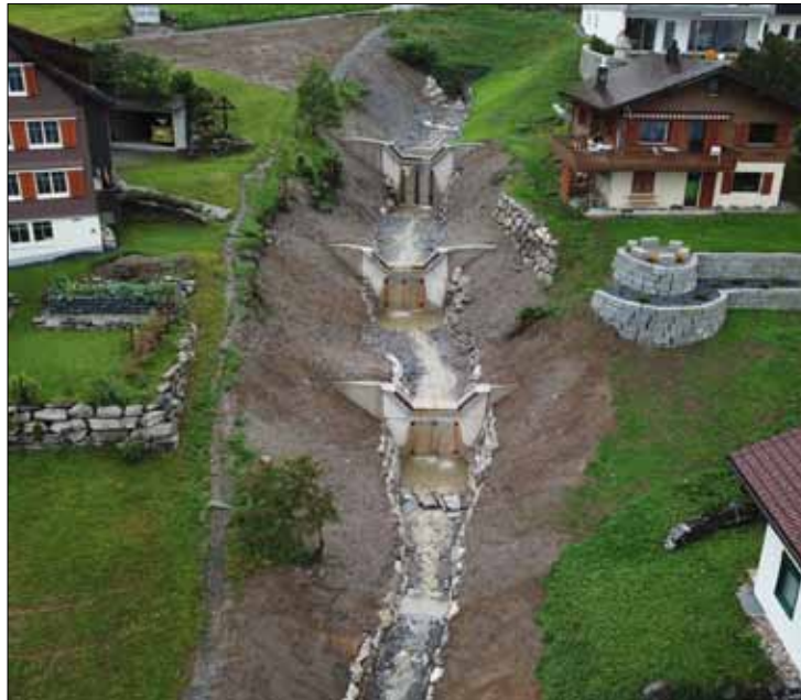
Die Baumeisterarbeiten beim Hochwasserschutzprojekt am Hänslibach sind abgeschlossen. Bild: Marc Thoma
