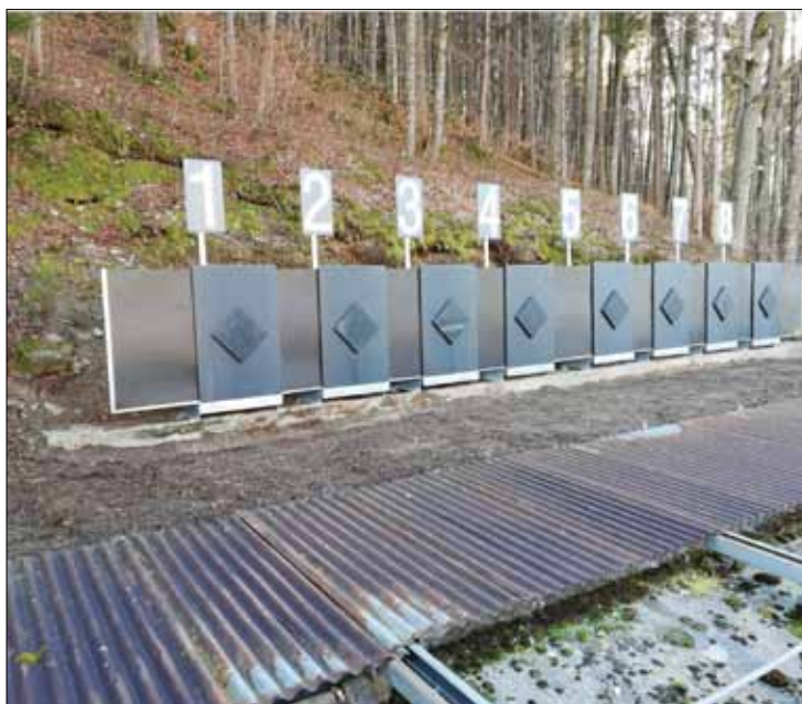
Der Stirnholzkugelfang beim Scheibenstand der 300 Meter Schiessanlage wurde durch ein künstliches Kugelfangsystem ersetzt.
