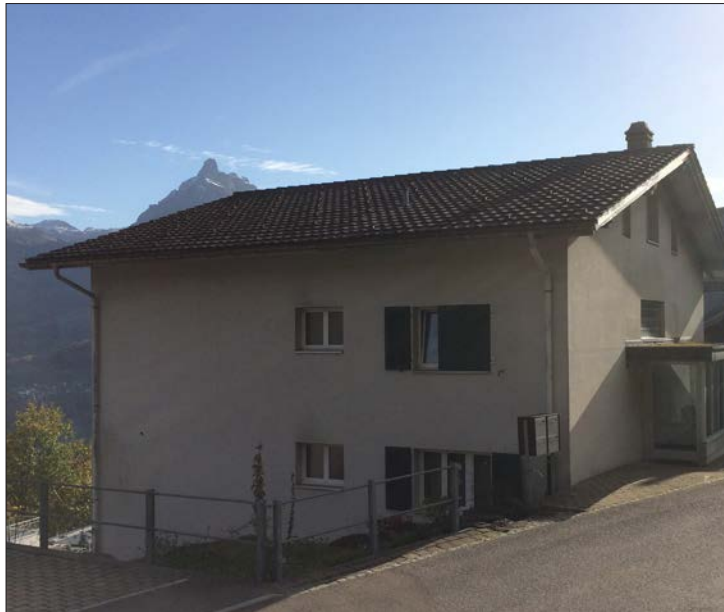
Das Mehrfamilienhaus an der Aeschenstrasse muss saniert werden. Bild: Roman Gmür
