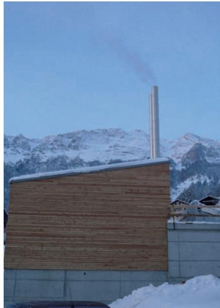
Dank einem Effort aller Beteiligten konnte am 16. Dezember die erste Probefeuering gemacht werden. Bis Weihnachten werden weitere Probefeueringen durchgeführt und alle Komponenten getestet. Das Holzschnitzelsilo wird gefüllt und im Januar können die ersten Wärmebezüge angeschossen werden. *Bild Emil Bischofberger*
