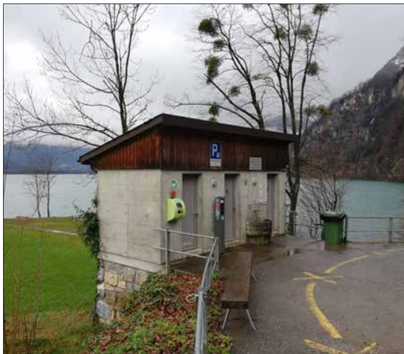
Die öffentliche Toilette in Betlis wird saniert.
